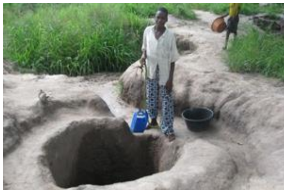
WS1 = 32 (บ่อขุดที่ไม่มีการป้องกัน)
